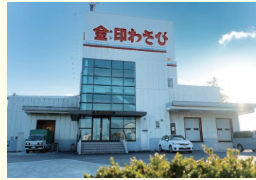
▲静岡工場外観
