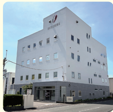
▲静岡工場本館
