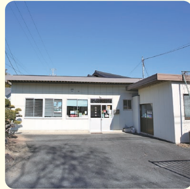
▲外観(事務所新築中)
